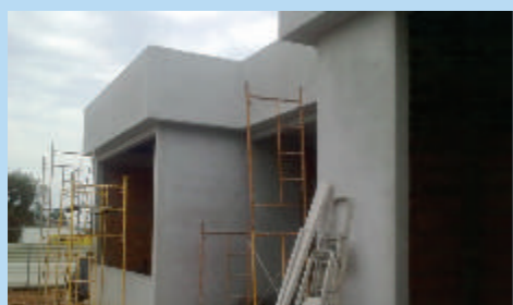
Obra em curso no município do Negage, província do Uíge.
